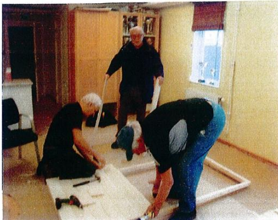
I dag är gruppen förstärkt med Mats L. här monterar han och Per-Erik gavlarna under sträng uppsikt av Kent.
