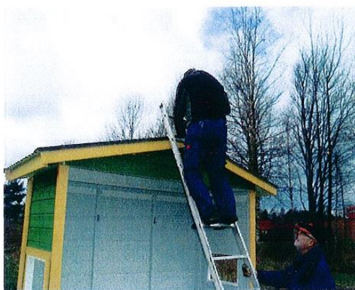
Vindskiveplåten skruvas fast, av P37 o Kennet håller stegen
