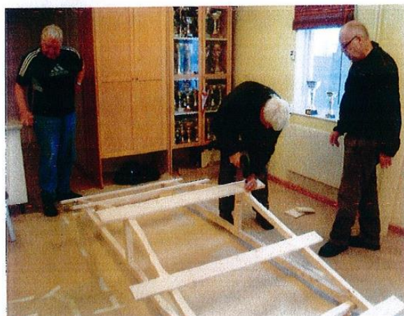
Mats, Per-Erik ock Kent bygger takmodulen.
